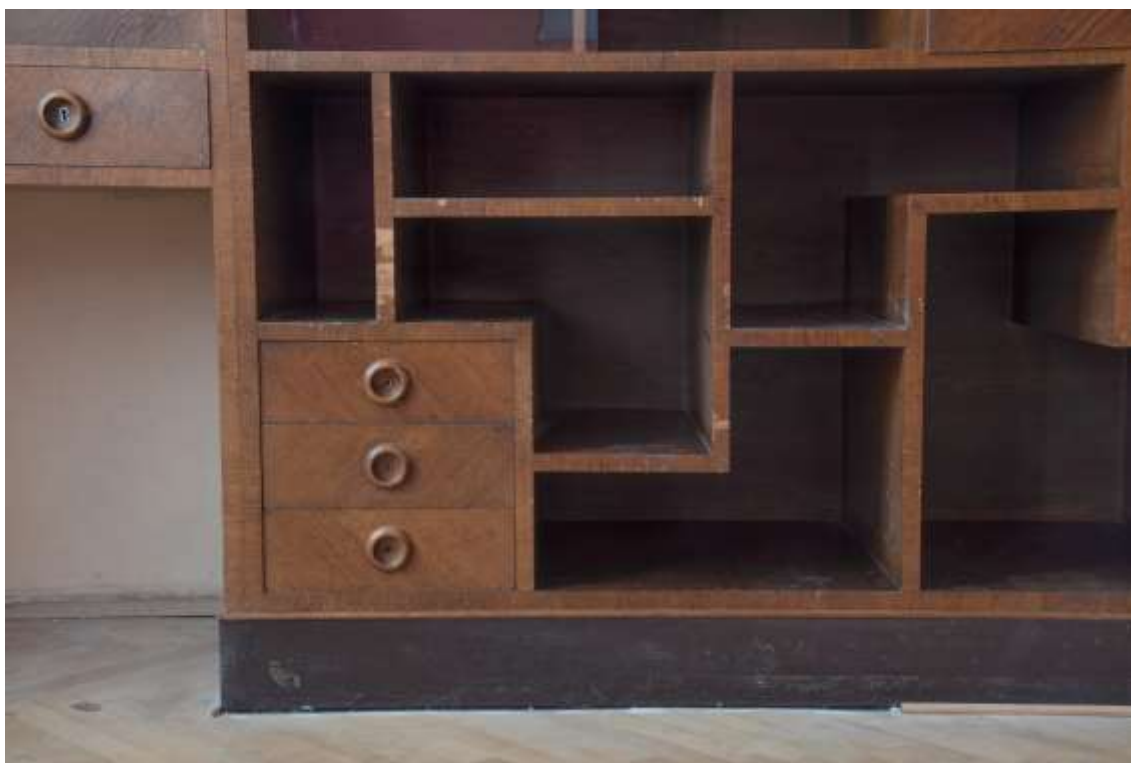
Chybějící dýha na čelních plochách dílce č. 2
