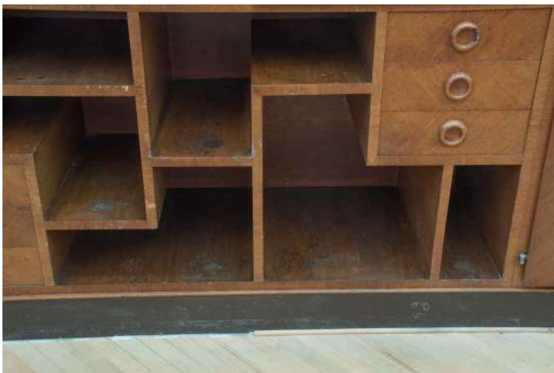
Skvrny na dýze polic v dílci č. 2, chybějící dýhy, oděrky na soklu, poškození kruhové úchytky zásuvky
