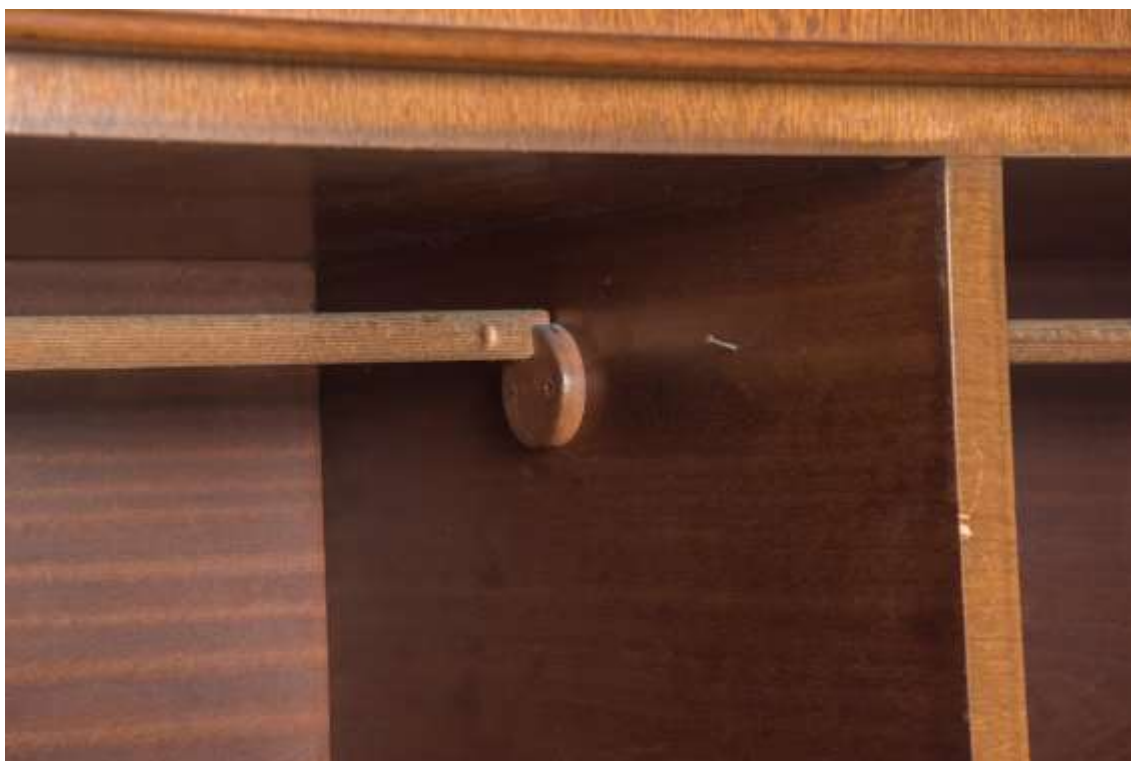
Detail tyče v šatní skříni, detail poškození – zatlučený hřebík
