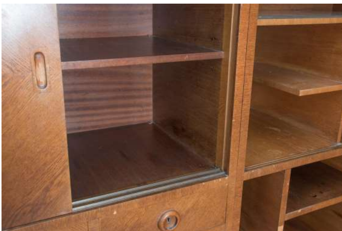
Skvrny v policích dílce č. 1 a dílce č. 2, chybějící dýhy, chybějící povrchová úprava v úchytce posuvných dvířek
