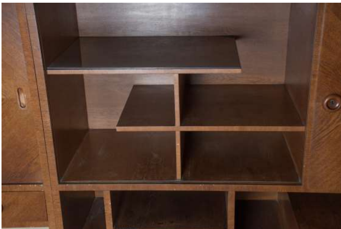
Skvrny v policích dílce č. 2, chybějící střípky dýhy na hranách polic
